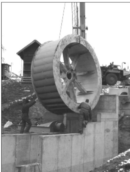
Am Mittwoch, 17. Dezember war es dann so weit. Mit einem grossen Pneukran wurde das vor Ort zusammengeschweisste, rund 2 Tonnen schwere Rad aus Edelstahl und Lärchenholz in die 4 Meter tiefe Radgrube hinuntergehievt und montiert. Die elektrischen Anschlüsse sowie die Abschlussarbeiten bis zur Inbetriebnahme des Kraftwerkes erfolgen im neuen Jahr. Im Juni ist eine offizielle Einweihung der Anlage vorgesehen.
